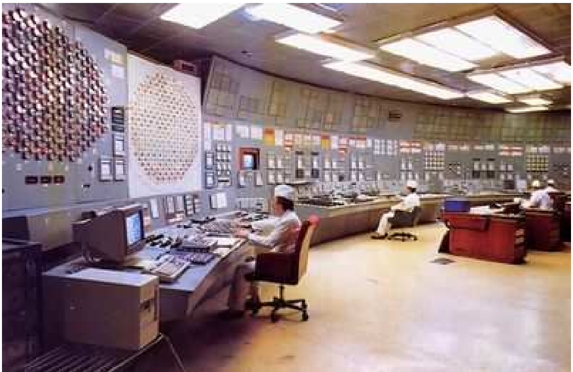
Rys. 8. Sterownia reaktora RBMK ( www.rosenergoatom.ru/ )
