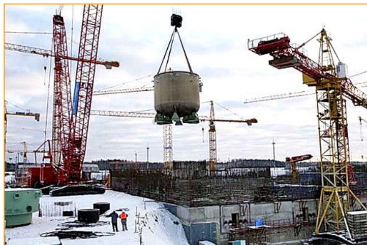
Rys. 9. Prace montażowe przy budowie
