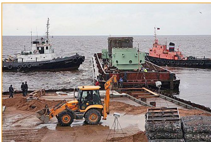
Rys. 6. Transport korpusu i zbiornika
