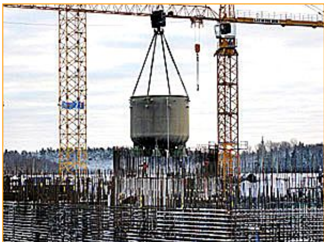
Rys. 8. Ładowanie zbiornika do szybu reaktora
